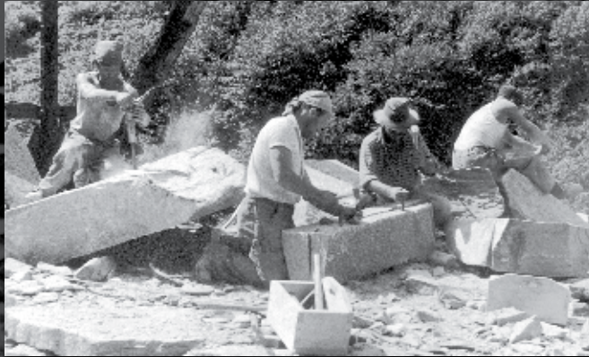
Operai intenti a realizzare cordòi (bordure per le strade). Sulla sinistra, si riconosce Albino Panscera. Al centro due operai che stanno spiodando una bóra per realizzare delle cordonà. Sulla destra Giovanni Lunardi con la ponciotéra. Sullo sfondo il braccio in legno di una gru, con il piantone in ferro. La cava è quella di Bruno Togni, agli inizi degli anni '60
